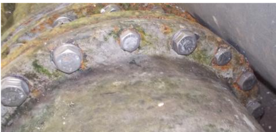
Rozměrově smíšené a nevhodné použití spojovacího materiálu
