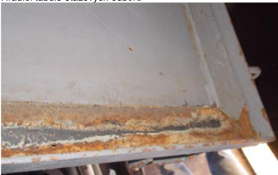
Detail poškozeného těsnění
