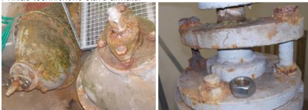
Chybějící kola, koroze prvků.
