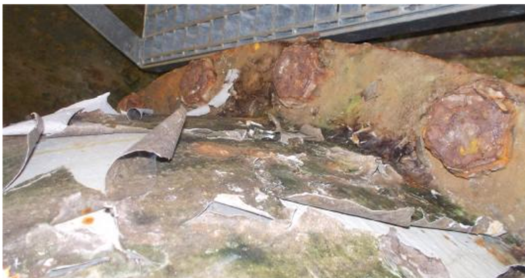
Koroze spojovacího materiálu a nefunkční PKO.
