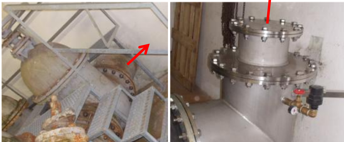
Napojovací body obtoku DN300
